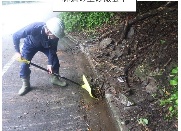
林道の土砂撤去中
