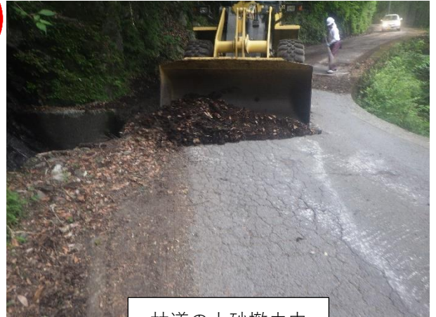
林道の土砂撤去中
